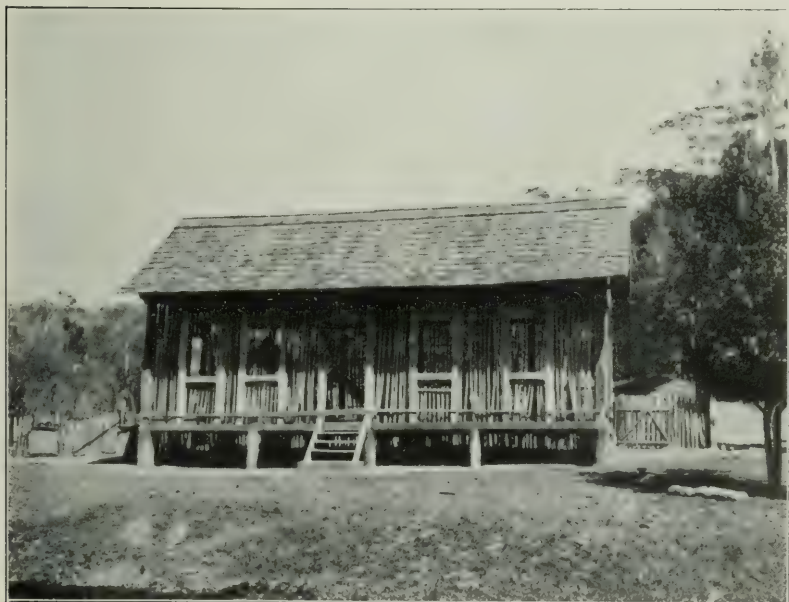
Haus im Bau.
